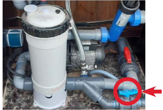
SCHRITT 2: Schließe den blauen Hebel, um den Abfluss im Hot Tub zu schließen (siehe Pfeil).
