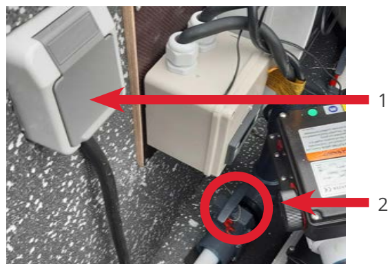
SCHRITT 6: Nach Benutzung des Hot Tub (spätestens bei Abreise) den Stecker aus der Steckdose ziehen (1), den Wasserhahn zum Entleeren wieder öffnen (2) und den Deckel schließen.
