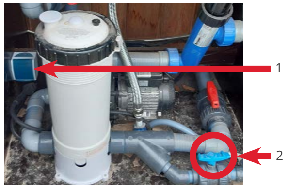
SCHRITT 6: Nach Benutzung des Hot Tub (spätestens bei Abreise) den Stecker aus der Steckdose ziehen (1), den Wasserhahn zum Entleeren wieder öffnen (2) und den Deckel schließen.
