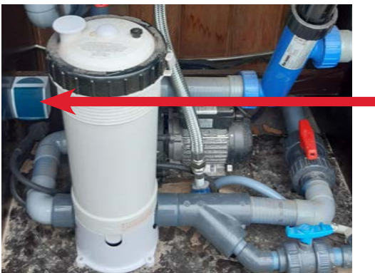
SCHRITT 5: Stecke den Stecker in die Steckdose, sodass die Pumpe anfängt zu arbeiten.
